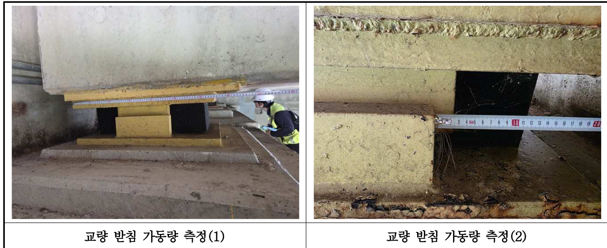
【사진 9.3.16】 교량받침 이동량 측정
