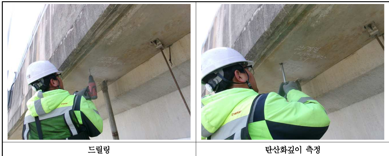
【사진 9.4.3】 탄산화 깊이 측정 현장사진
