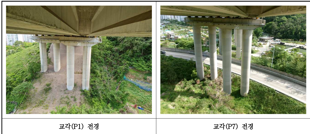
【사진 9.3.10】 교각 전경
