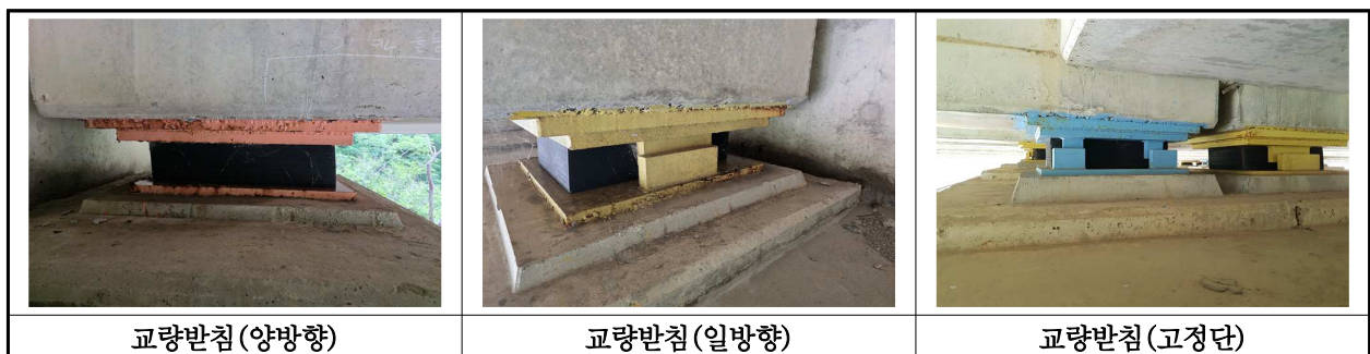
【사진 9.3.13】 교량받침 전경
