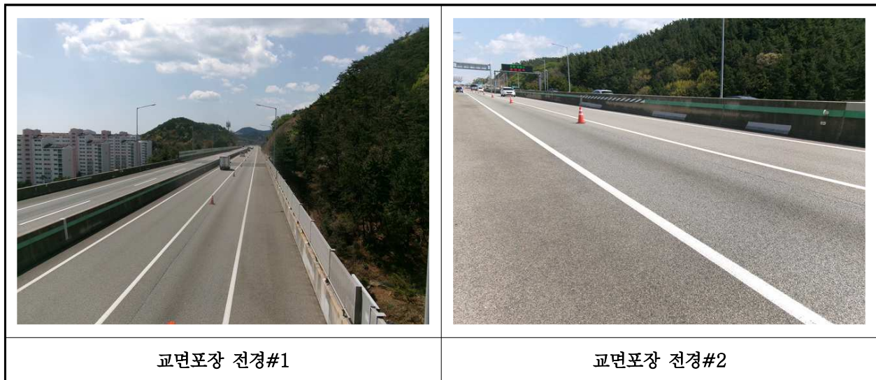
【사진 9.3.20】 교면포장 전경
