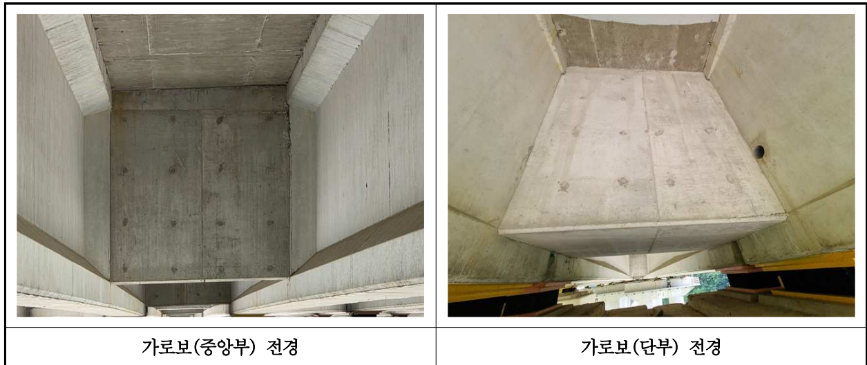
【사진 9.3.6】 가로보 전경
