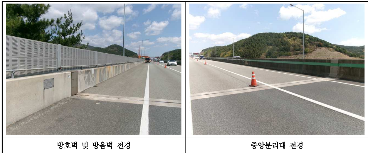
【사진 9.3.24】 방호벽 및 중분대 전경
