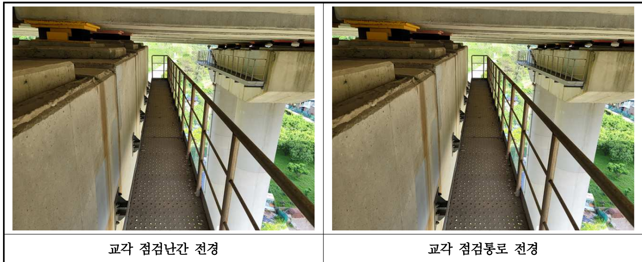
【사진 9.3.26】 교량 점검시설 전경
