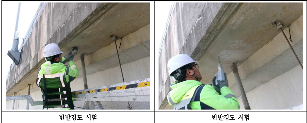
【사진 9.4.2】 반발경도시험 현장사진
