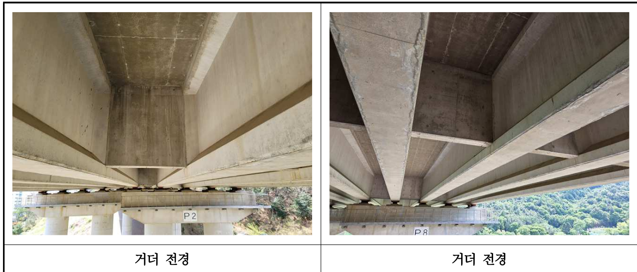
【사진 9.3.4】 거더 전경
